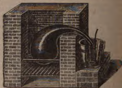
Фиг. 5. Перегонка фосфора
